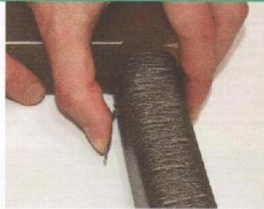
traversez la mousse sur toute son épaisseur. Verrouillez en pliant l'épingle sous la mousse. Renouveler l'opération sur le deuxième morceau de mousse.
